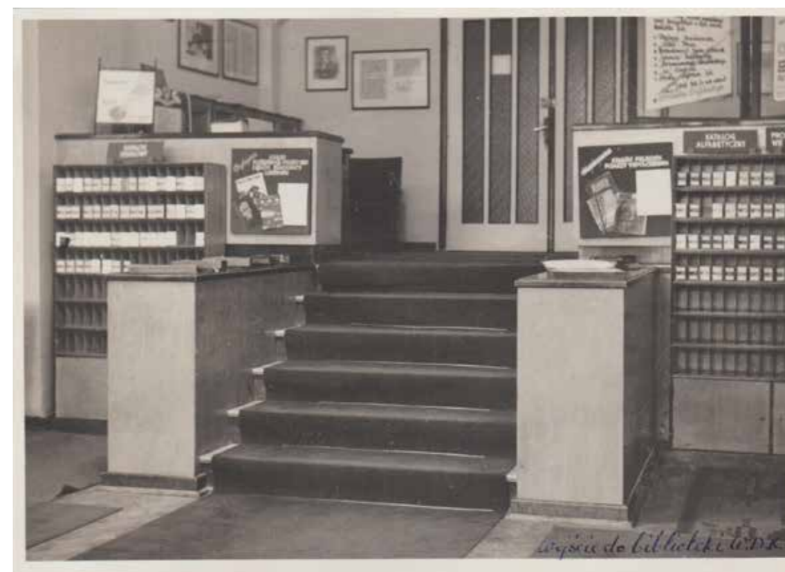
1957, autor nieznany [źródło: Archiwum Łódzkiego Domu Kultury 1957] wejście do biblioteki
