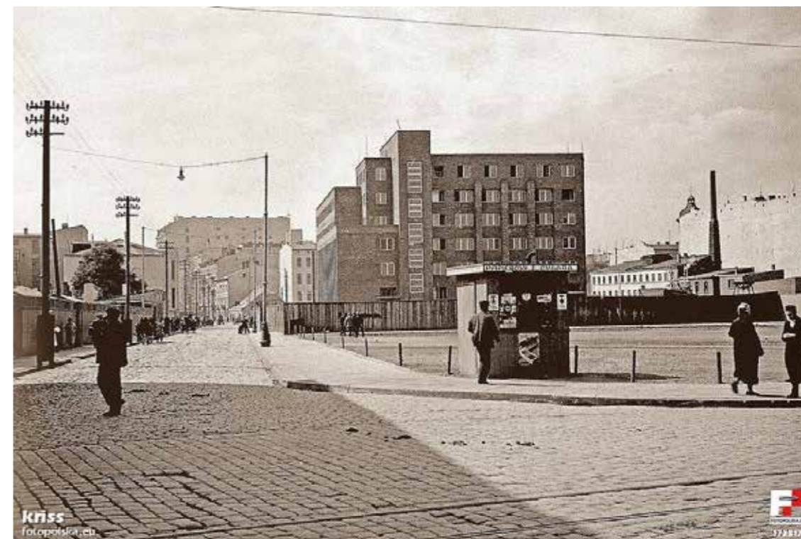
ul. Traugutta 18 – gmach Domu Pomnika w stanie surowym, 1937 autor Włodzimierz Pfeiffer, źródło: Sentymentalna podróż po Łodzi, opr. zbiorowe, Łódź 2009
